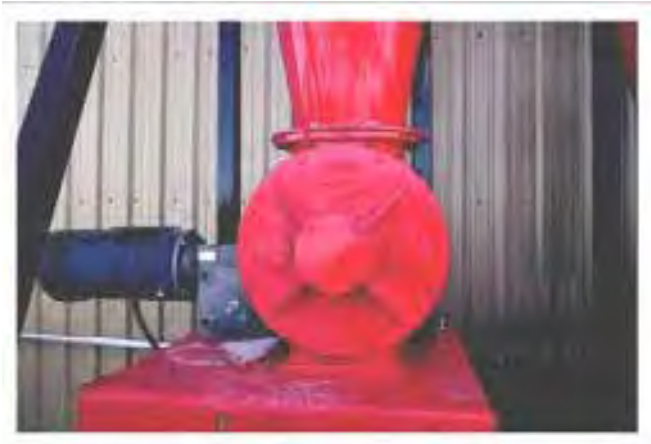
FIG. 17 AIRLOCK ACCESS DOOR
